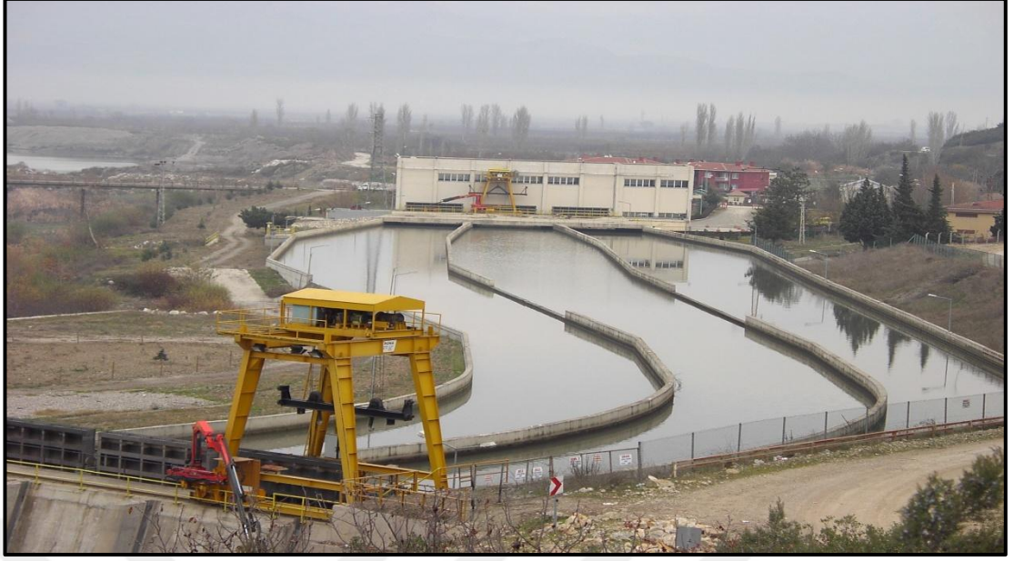
Şekil 3.7. Pamukova HES İletim Kanalları
