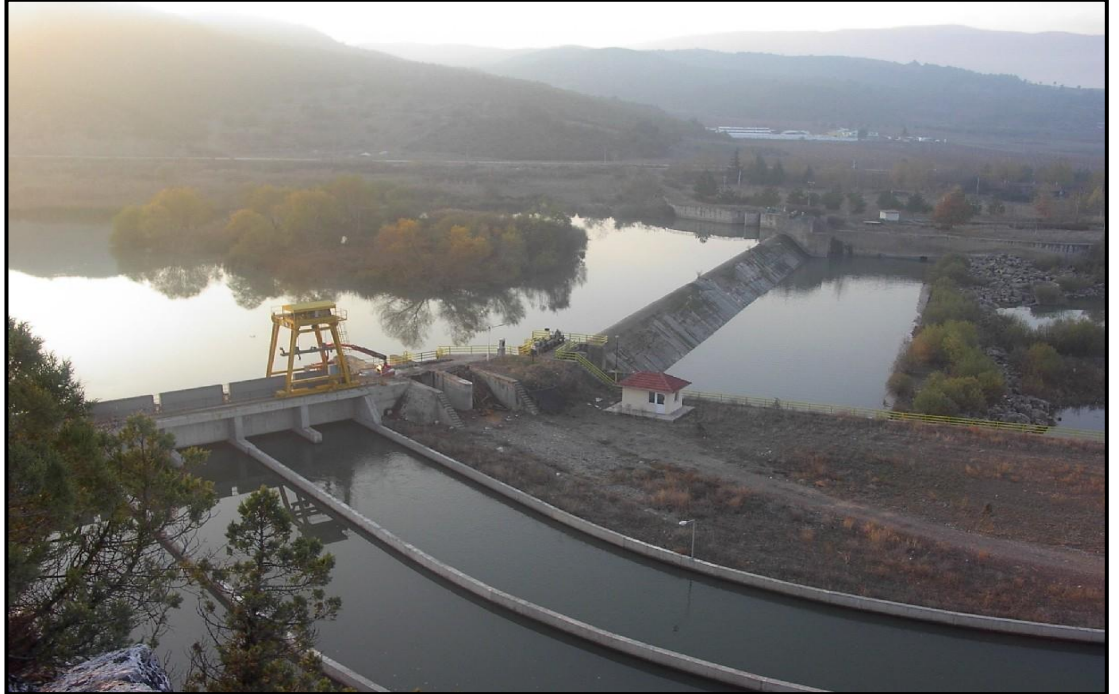
Şekil 3.6. Pamukova HES Su Alma Yapısı
