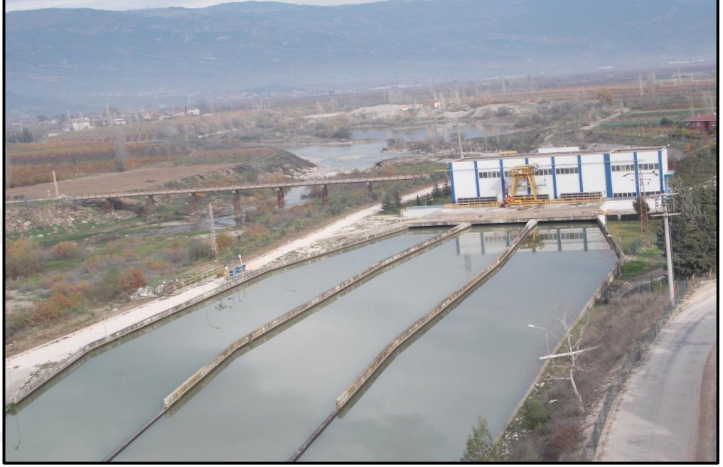
Şekil 1.4. Hidroelektrik İletim Kanalları (Pamukova Hes)
