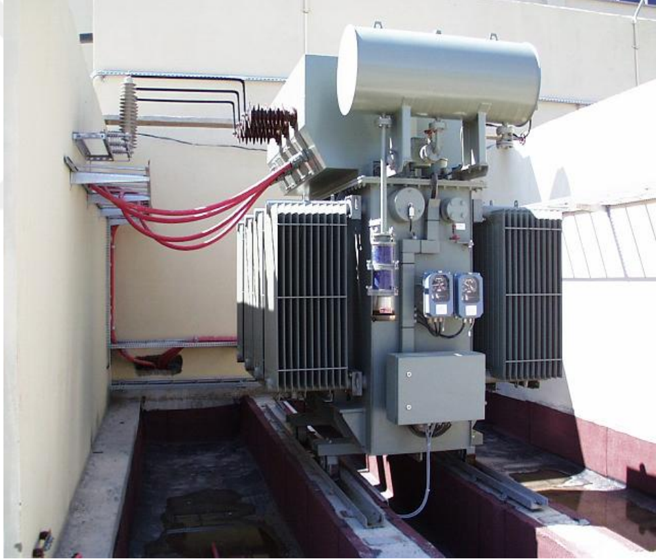
Şekil 3.4. 3600 KVA Transformator
