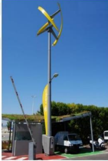
Şekil 1.13 : Sanya Skypump dikey rüzgar türbinine sahip şarj istasyonu(Inhabitat, 2011)
