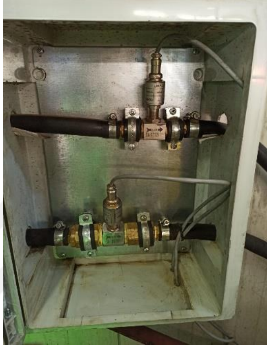
Şekil 4.5. Türbin tipi debi ölçerler
