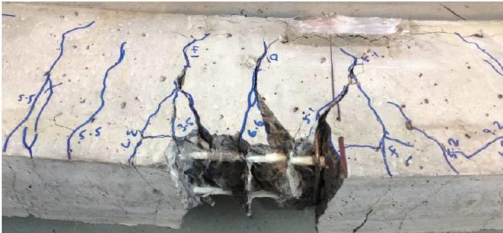
Şekil 2. GFRP Donatılı Kirişin Eğilme Deneyi Sonucunda Oluşan Hasar (Remennikov et al., 2016)
