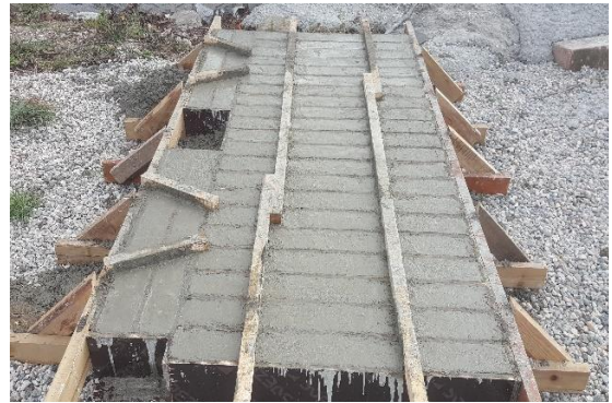
b) Tamamlanan beton dökümü
