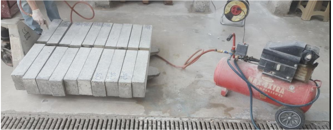
d) Basınçlı hava ile yüzey temizliği
