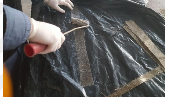
d) Rulo yardımıyla kumaşların epoksiye doyurulması
