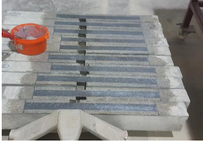
Şekil 3.16. BFRP kompozit yapıştırma işlemi tamamlanan numuneler.
