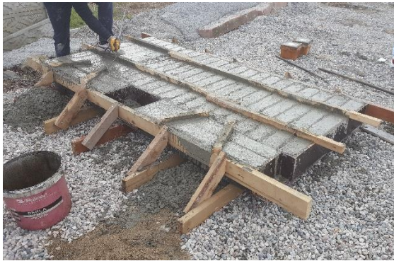
a) Beton tesviye ve yerleştirme işlemi
