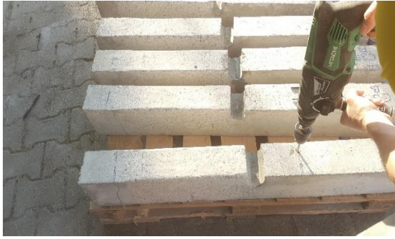
a) Ankraj deliklerinin açılması
